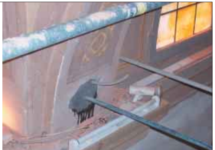
Fig. 18: Intervento 4: Spostamento e sostituzione di catene con inserimento di nuove barre allo scopo di allineare gli assi dei vincoli e di introdurre quelli mancanti
