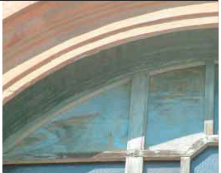
Fig. 16: Intervento 2: rinforzo del bordo delle aperture mediante barre di C-FRP inserite nei corsi sottostanti la finestra e tessuto nello stipite curvo superiore
