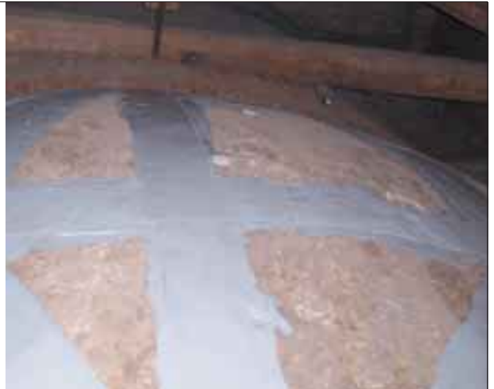
Fig. 17: Intervento 3: rinforzo delle volte e delle cupole mediante realizzazione di una rete di strisce di G-FRP secondo meridiani e paralleli
