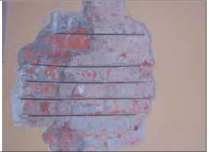
Fig. 21: Intervento 8: repointing dei giunti di malta con inserimento di armature a taglio costituite da barre Ø 4 mm in C-FRP
